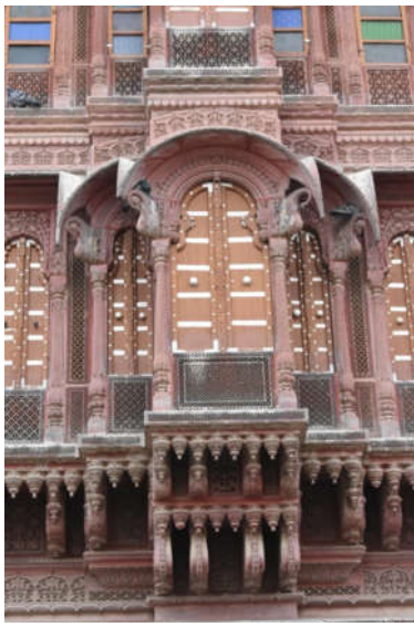
Fig. 3 : Jharokha (P. C. Kothari Haveli) (Source : Self)
